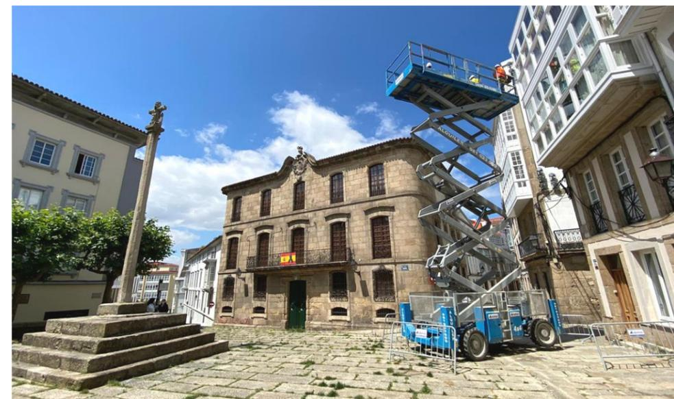
Figura 1. Inspección da envolvente exterior da Casa Cornide desde Inspección plataforma elevadora
