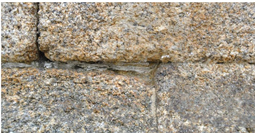
Figura 6. Detalle de junta con conchas de ostra calzando entre los sillares de la esquina SE del edificio.
